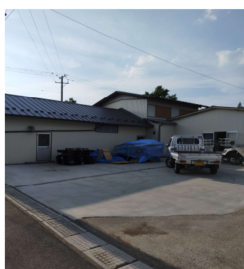
解体撤去した広々とした 空間に、新たな農機具倉庫 (写真右側)
