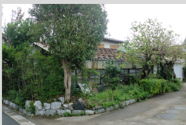
古い農機具小屋と樹木の撤去 後方の作業場の屋根・外壁の改修
